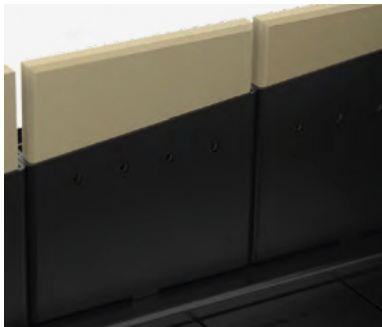
Renfort intérieur en vermiculite et en acier.
